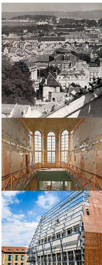
Construction de la structure extérieure du nouveau bâtiment
