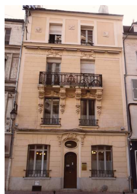
MAISON 18 E . RESTAURATION DE QUALITE DE LA FACADE D'UN IMMEUBLE (ENDUIT, FERRONNERIE) RUE ST ETIENNE
