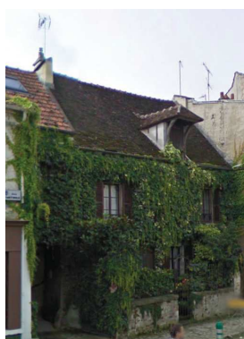
BÂTI D'ORIGINE RURAL. CONSERVATION DES DISPOSITIONS D'ORIGINE. RUE DU FBG ST NICOLAS
