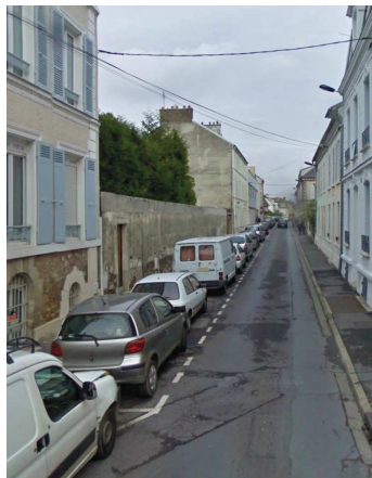
RUPTURE DU FRONT BÂTI À L'ALIGNEMENT RUE SAINT FARON
