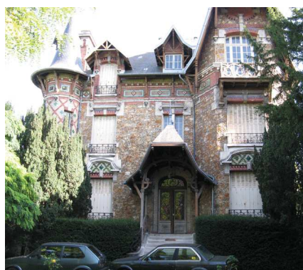
VILLA 19 EME SECLE. CONSERVATION DES DISPOSITIONS D'ORIGINE. RUE DES CORDELIERS
