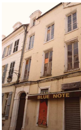
2/ SUPPRESSION DES MENUISERIES (CONTREVENTS) RUE ST CHRISTOPHE
