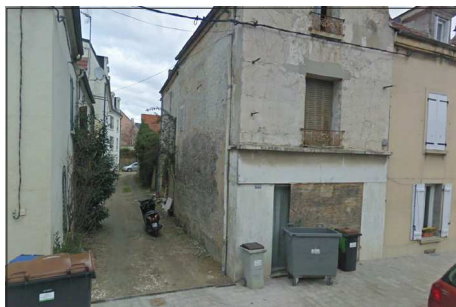
E - 105 RUE DU FAUBOURG SAINT NICOLAS COURS OUVERTE SUR RUE
