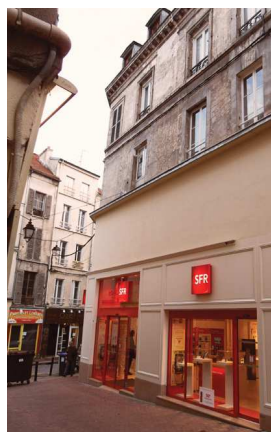
1/ SUPPRESSION DE L'ENSEMBLE DE LA STRUCTURE DE LA FACADE RUE DARNETAL
