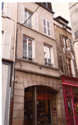
3/ ENDUIT CIMENT ET SUPPRESSION DES MODÉNATURES RUE DE LA CORDONNERIE
