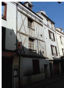
FAÇADES EN MATÉRIAUX DESTINÉS À RESTER APPARENTS :
