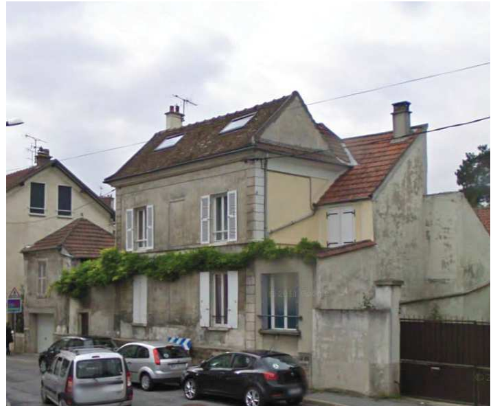
MAISON 18E-19E. DE MULTIPLES EXTENSIONS ONT TOTALEMENT DÉNATURÉ LE VOLUME INITIAL DU BÂTI RUE DE CHAAGE
