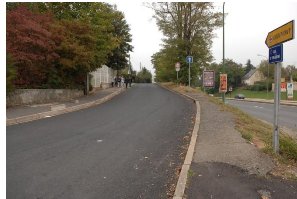
Réfection de la voirie rue d'Orgemont
